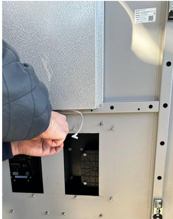
Dopo aver fissato il carter alla colonnina è possibile collegare il terminale all'alimentazione e alla rete con i due cavi ethernet già predisposti nella colonnina.
