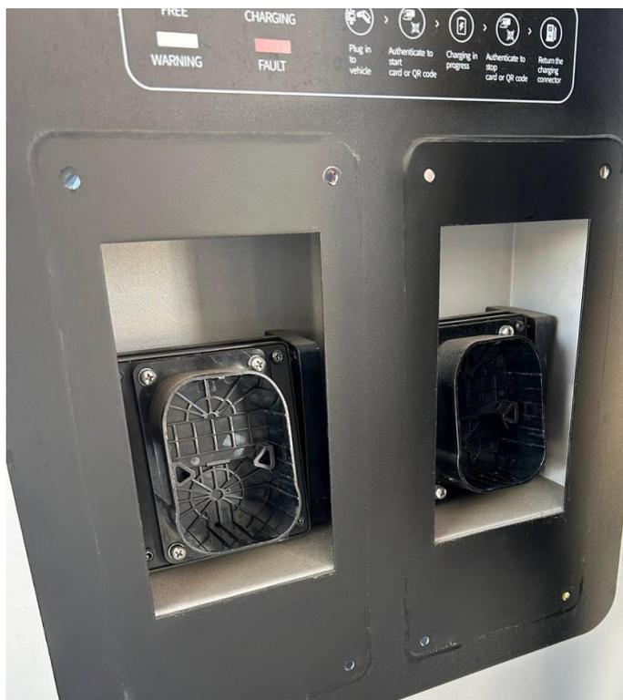
Successivamente, aprire la colonnina e rimuovere il box (svitando i bulloni di fissaggio) che conteneva le prese smontate in precedenza.
