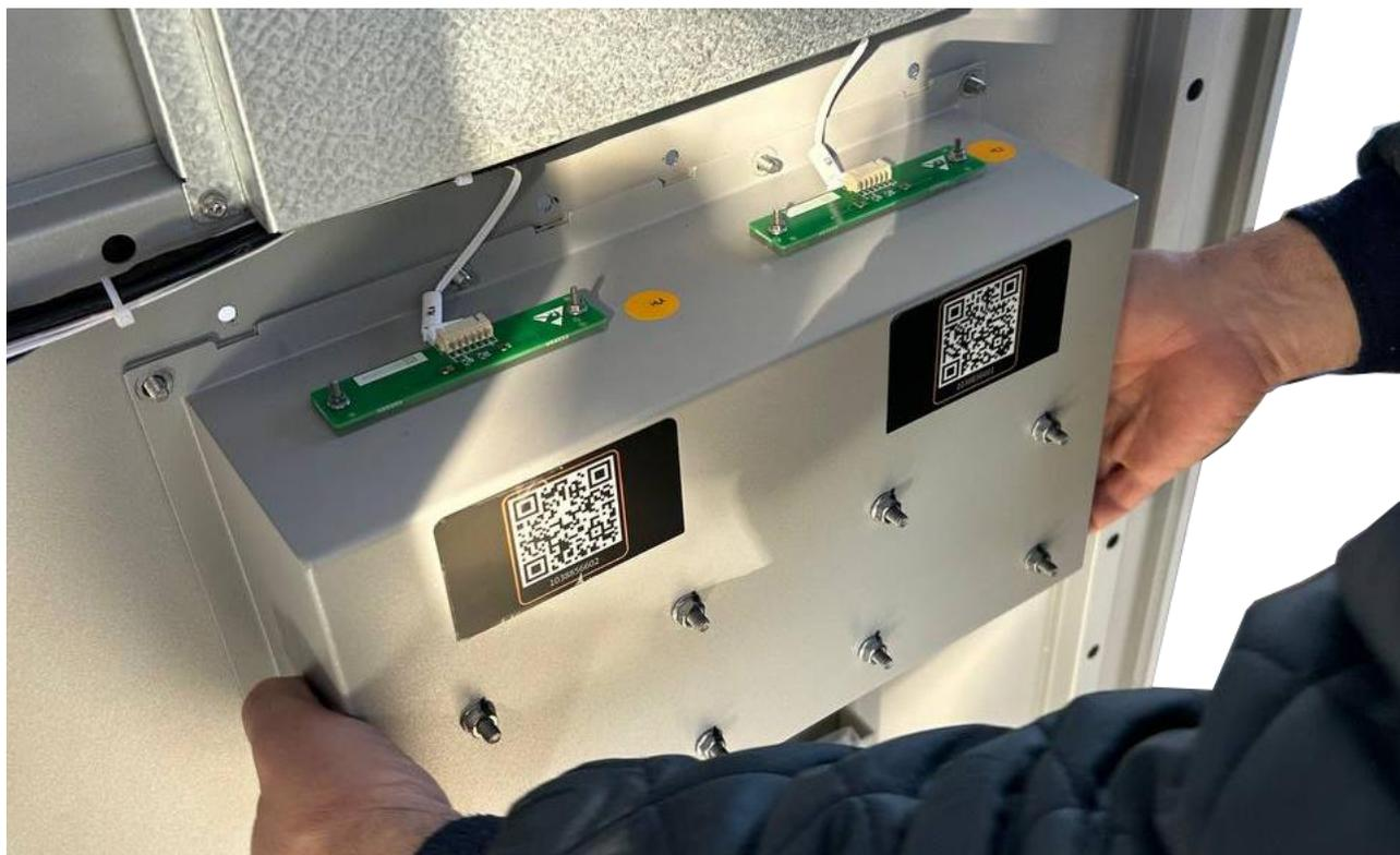
Posizionare il terminale sul carter e verificare con una livella che il terminale sia posizionato correttamente.
